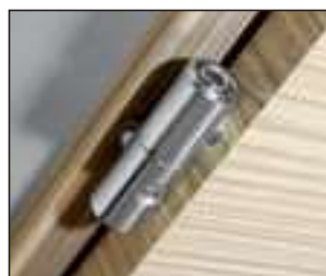
Particolare di anubatura tra anta e telaio Hinge details between leaf and frame
